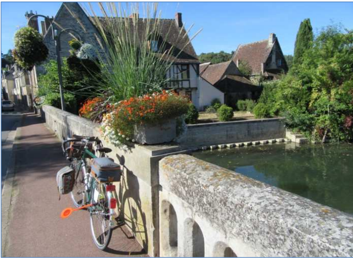
Le pont fleuri de Montoire.
