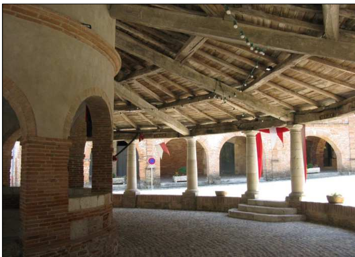
Sous la halle ronde.
